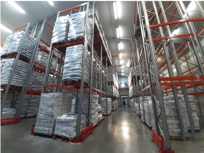
Chambre froide avec 1200 emplacements
