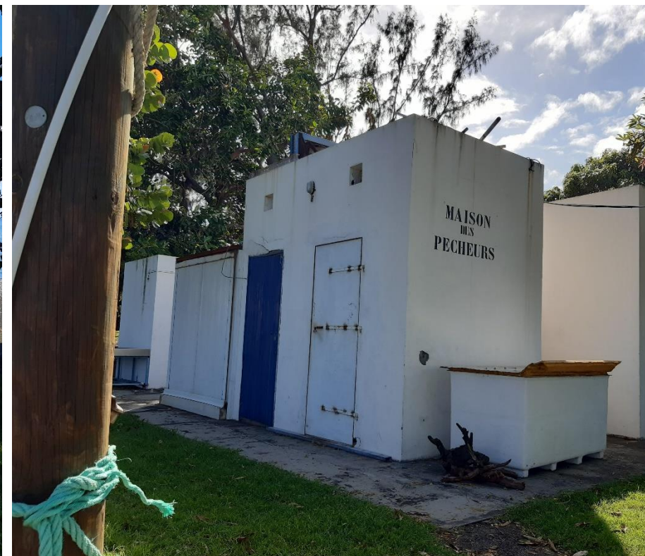
Box de stockage
