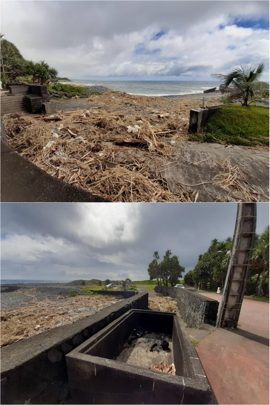
Rampe d'accès à la marine
