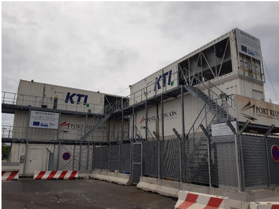
Nouveaux silos à glace n°4 et 5
