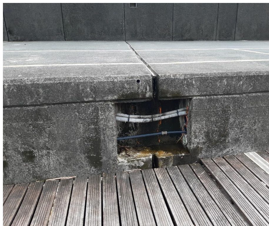
Installations actuelles obsolètes sur les réseaux eaux et électricité
